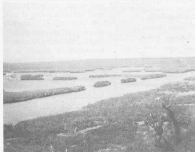
Laguna morta con barene conformate ad isolotti: ponte ferroviario Venezia - Mestre.
